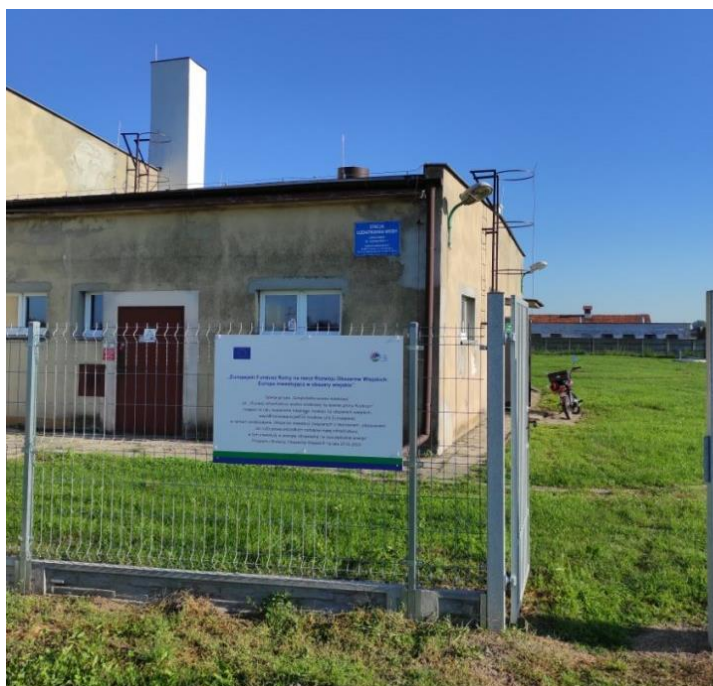
Stacja Uzdatnia Wody w Czerlejnku
