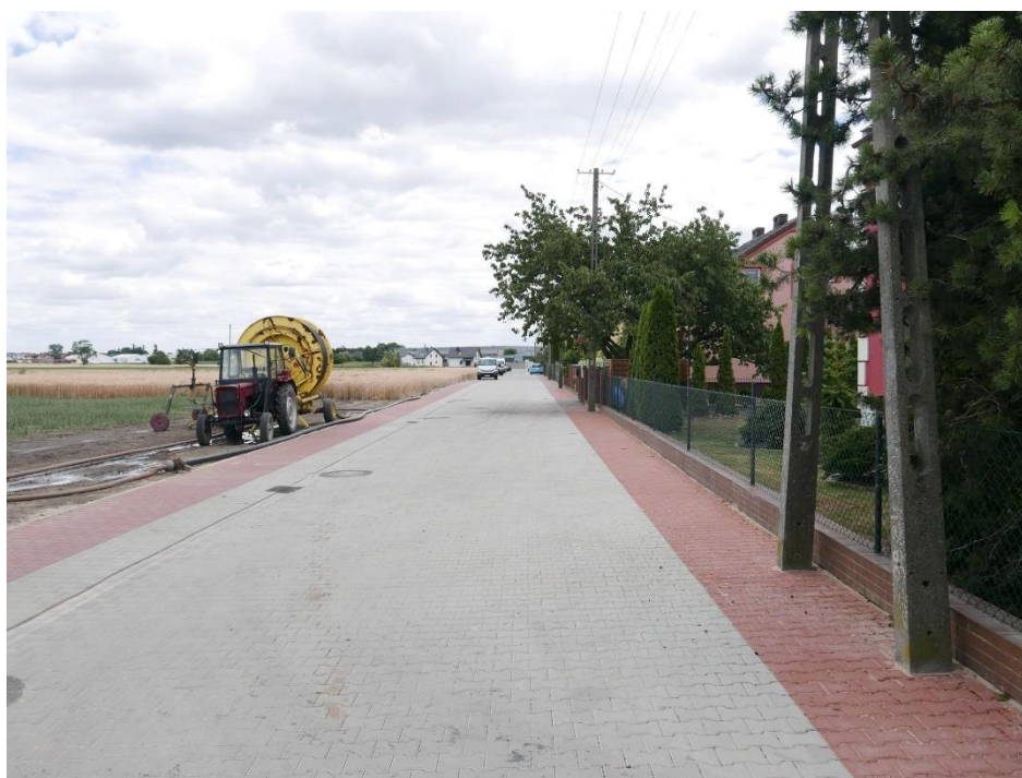
Budowa ul. Rolnej w Kostrzynie
