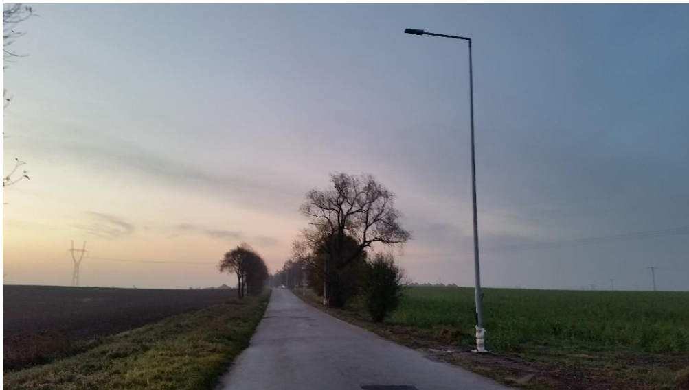
Oświetlenie drogi gminnej z Kostrzyna do Gwiazdowa
