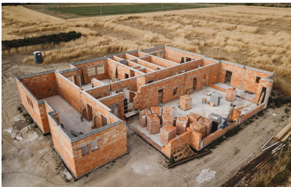
Budowa Przedszkola przy ul. Powstańców Wlkp. w Kostrzynie – lipiec 2019
