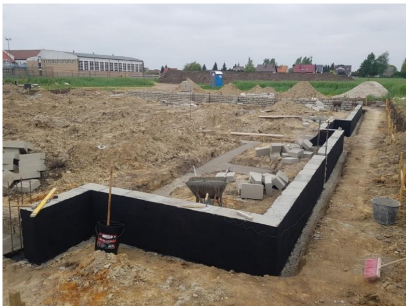
Budowa Przedszkola przy ul. Powstańców Wlkp. w Kostrzynie – kwiecień 2019
