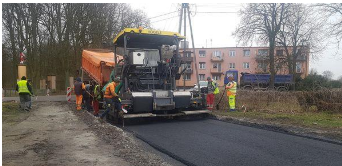
Budowa drogi w Siedlecu
