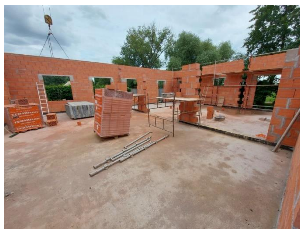
Budowa – Żłobek w Siekierkach Wielkich
