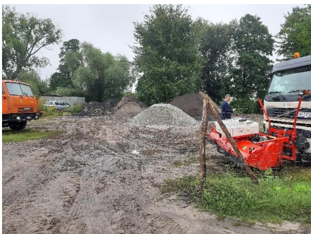
Teren pod budowę Żłobka w Siekierkach Wielkich
