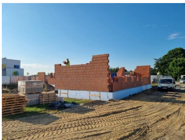
Budowa – Żłobek w Kostrzynie
