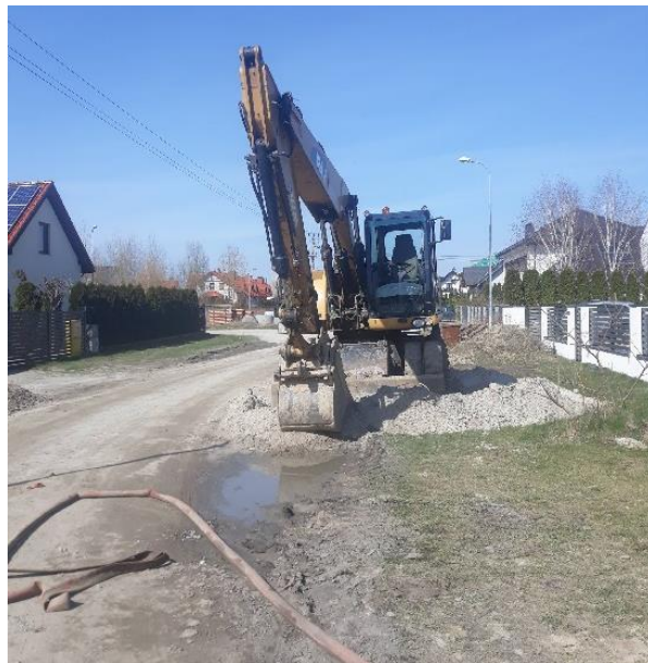
Budowa kanalizacji sanitarnej w Siekierkach Wielkich
