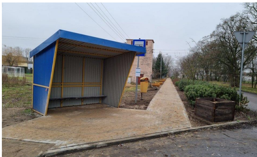
Przebudowa chodnika w Drzążgowie
