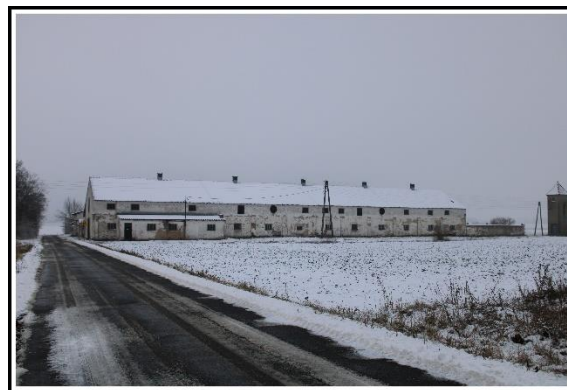
Budynki po byłym SKR
