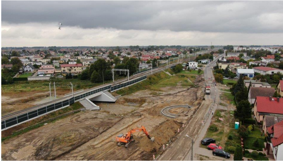
Postępy prac przy budowie tunelu w Kostrzynie – październik 2020 r.
