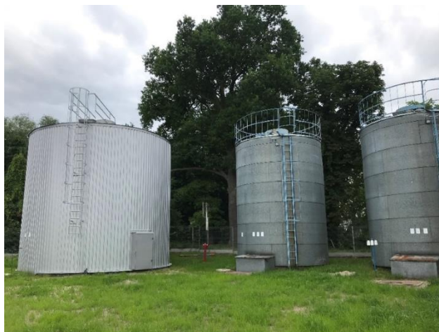
Zbiornik retencyjny na terenie Stacji Uzdatniania Wody w Siekierkach Wielkich
