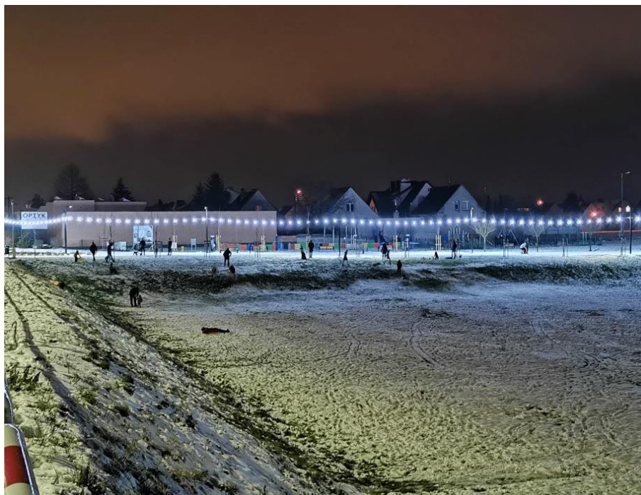
Ścieżka pieszo-rowerowa przy placu Kurdeszowym w Kostrzynie z nowym oświetleniem
