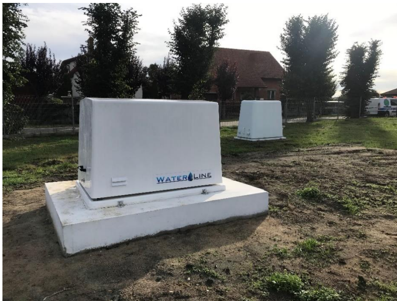
Obudowa studni głębinowej na terenie Stacji Uzdatniania Wody w Gułtowach
