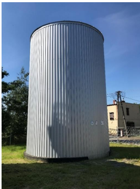
Zbiornik retencyjny na terenie Stacji Uzdatniania Wody w Gułtowach
